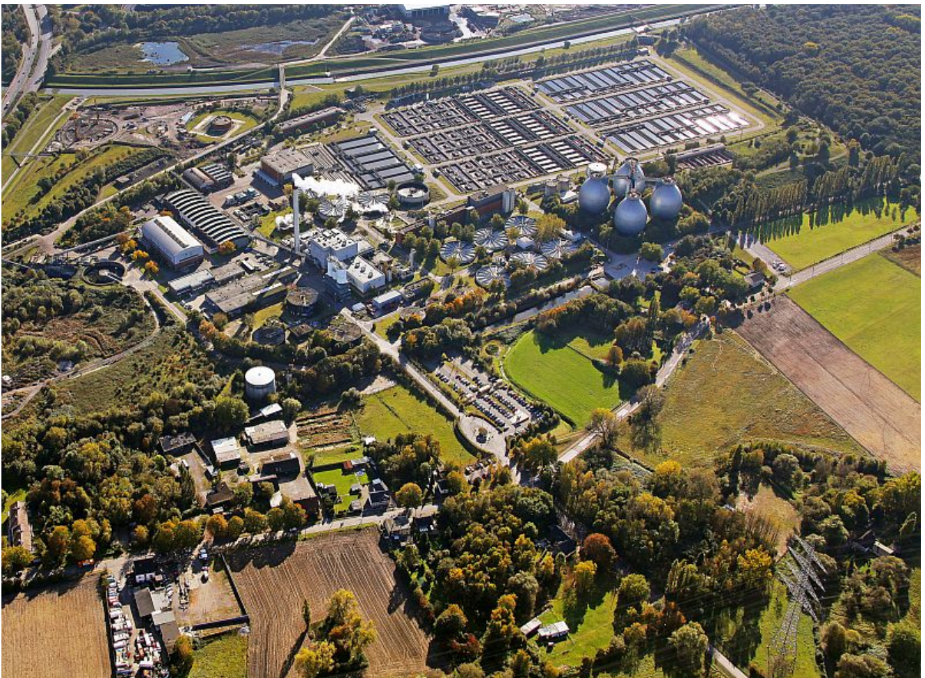
Kläranlage Dortmund Deusen, Foto: Luftbild Hans Blossey,
