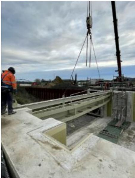
Das Verschlussbauwerk ist als U-förmige Betonkonstruktion mit seitlichen Führungsschienen gestaltet, in das die stählernen Dammbalken, mit einem Mobilkran von oben eingesetzt und aufeinandergestapelt werden. Dieser Arbeitsschritt markiert den Beginn der letzten Bauphase an der Ein- und Ausfahrt des Adensees. Nach dessen Fertigstellung wird dieser Bereich geflutet und später mit dem Kanal verbunden.
