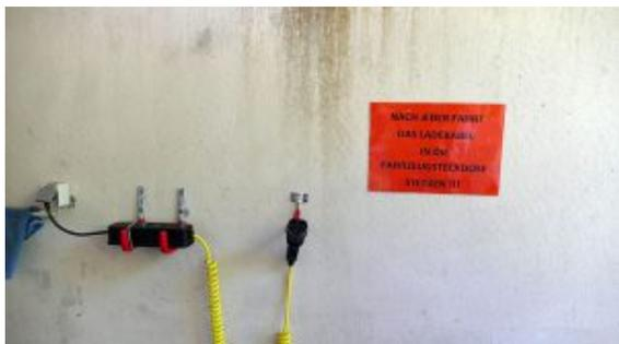
Die Ladestation in der Garage mit der Mahnung, vor dem Start das Kabel aus der Steckdose am Auto zu ziehen.
