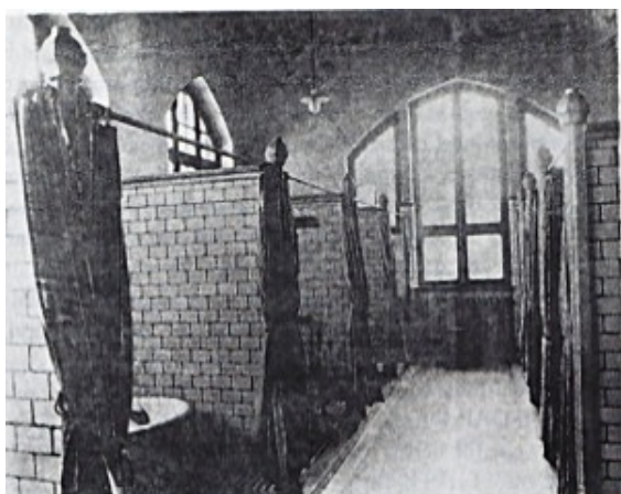
Waschkabinen im Wohlfahrtsgebäude
