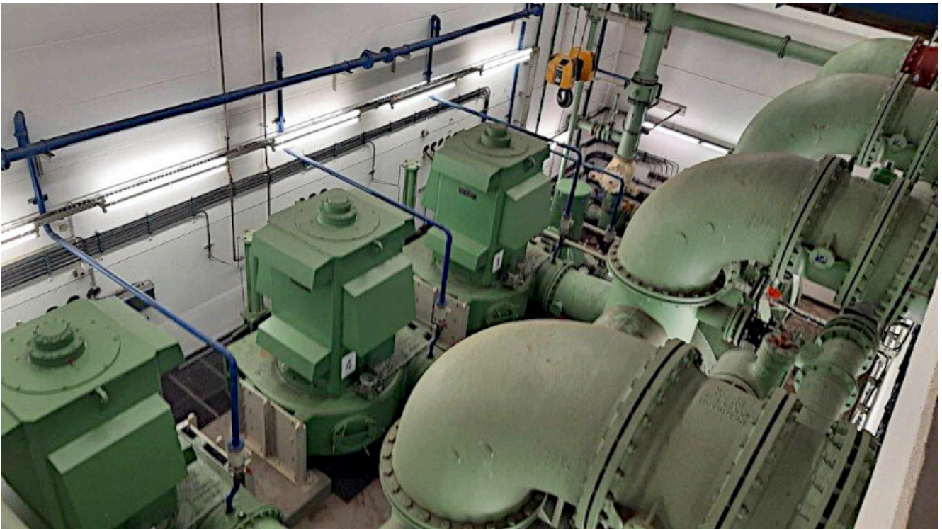
Pumpwerk Beverbach in Rünthe. Foto: Aktionskreis / Röcher
