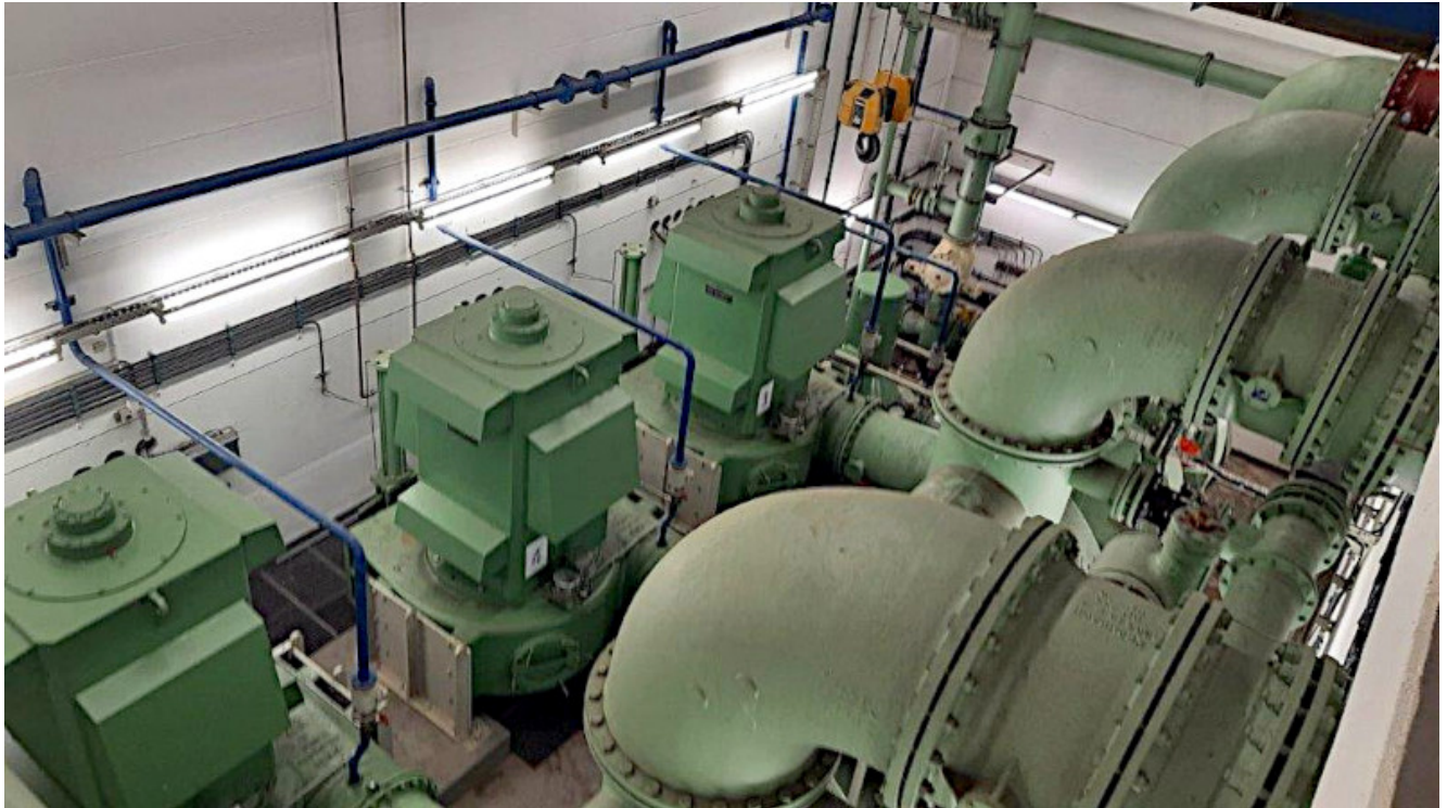
Pumpwerk Beverbach in Rünthe. Foto: Aktionskreis / Röcher
