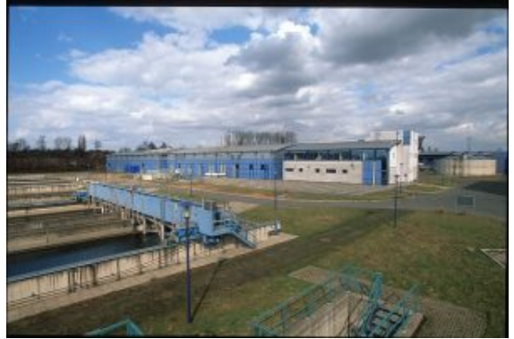
Die Kläranlage (KLG) Kamen-Körnebach.
