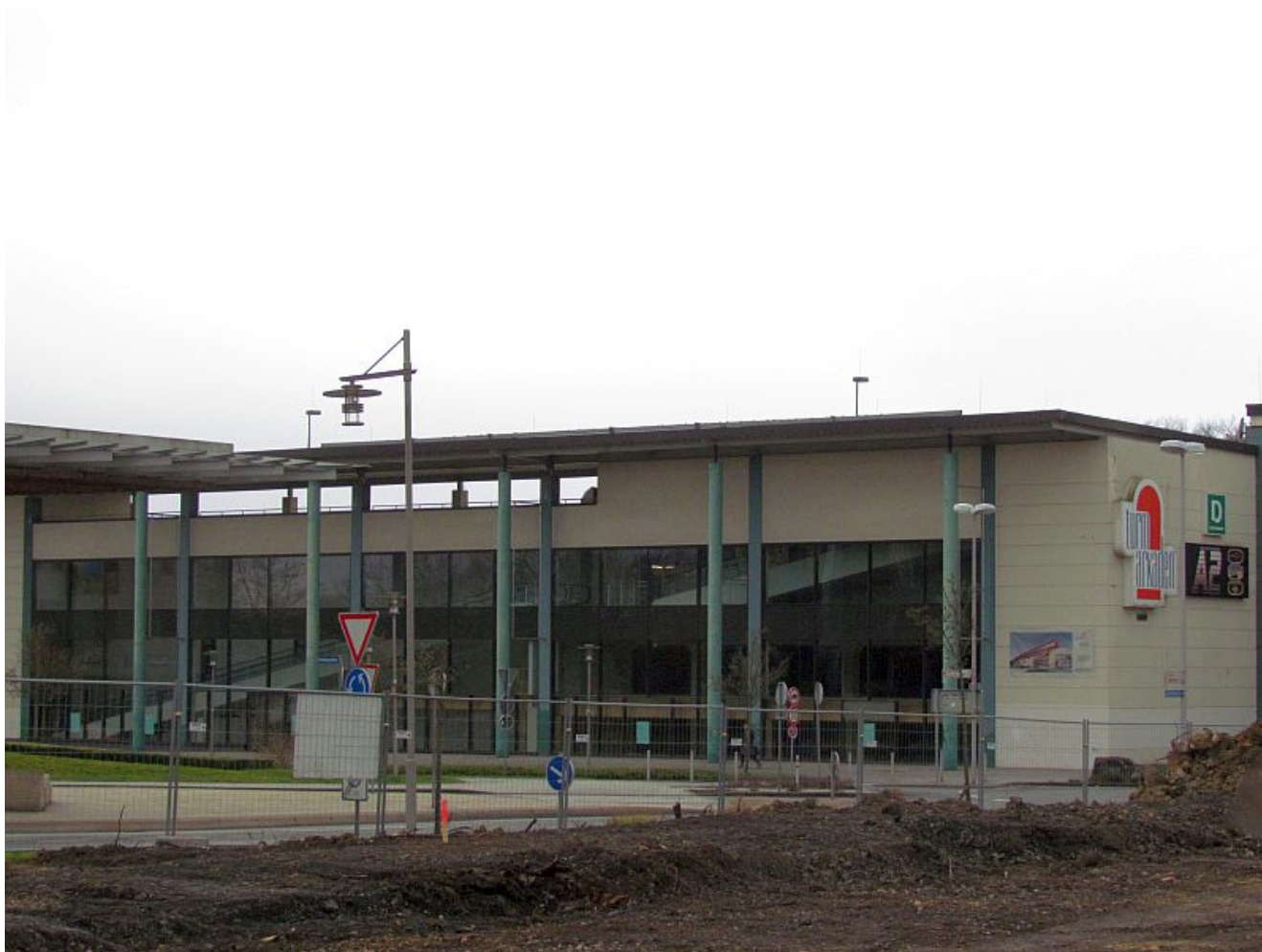
Die Turmarkaden mit Blick von der Sparkassen-Baustelle
