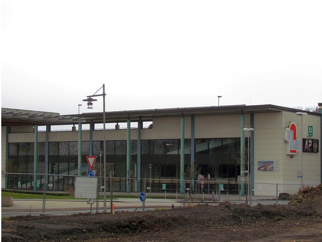
Die Turmarkaden mit Blick von der Sparkassen-Baustelle
