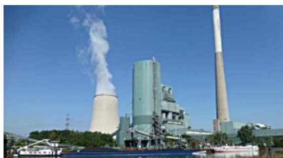
Das Steinkohlekraftwerk in Heil.
