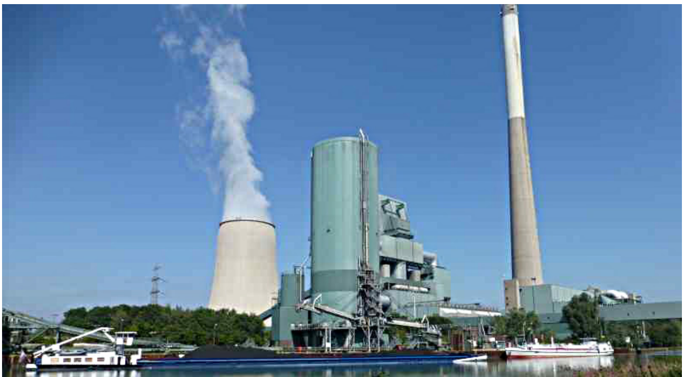
Das Steinkohlekraftwerk in Heil.
