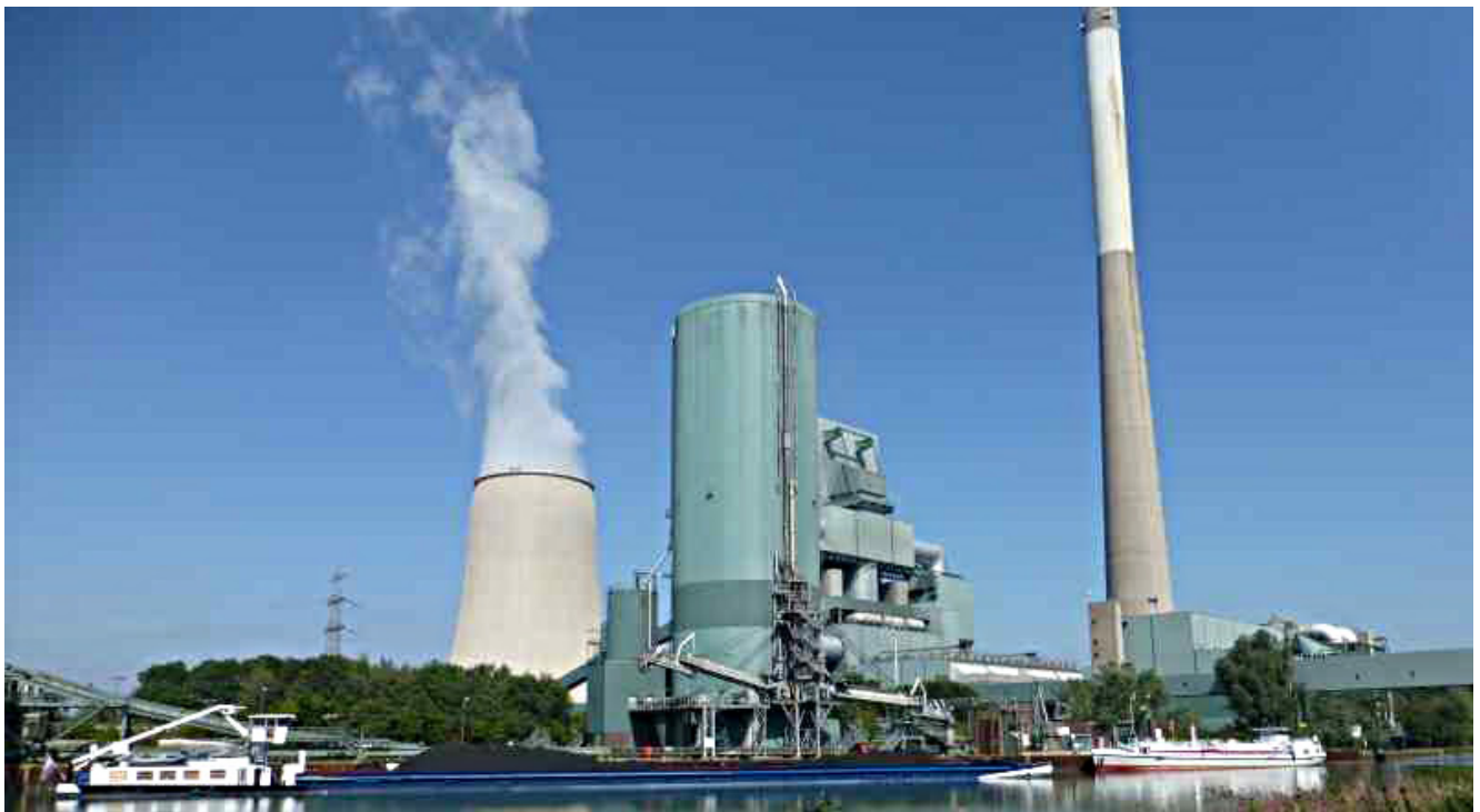
Das Steinkohlekraftwerk in Heil.
