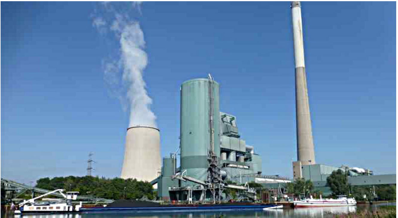
Das Steinkohlekraftwerk in Heil.
