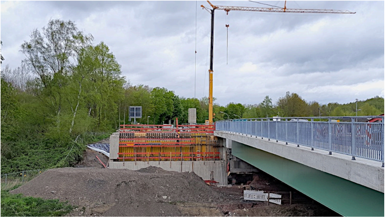
Die neue Lippebrücke vor dem Verschub. Foto: Straßen NRW
