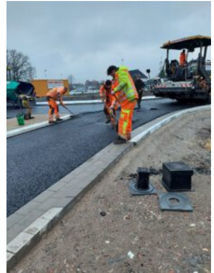
Asphaltarbeiten am nördlichen Kreisverkehr. Foto: Ludewig+Bock
