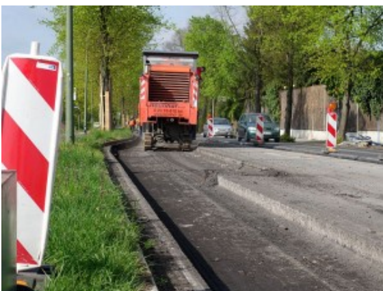
Asphaltfräse auf der Landwehrstraße
