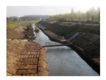
Der aktuelle Abschnitt schließt an die bereits erfolgte Umgestaltung bis zum Asternweg an und endet am Düker, in dem die Seseke den Schifffahrtskanal unterquert. Die Deiche in diesem Abschnitt müssen bleiben, weil sie nicht allein für das Hochwasser der Seseke
