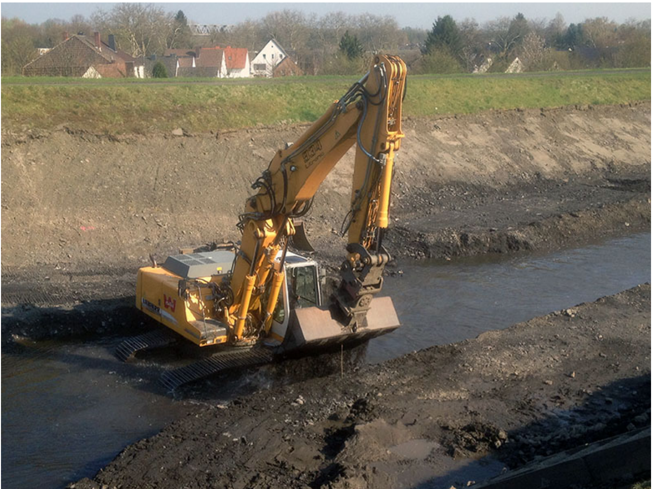
Bagger im Unterlauf der Seseke
