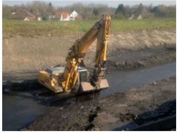
Bagger im Unterlauf der Seseke
