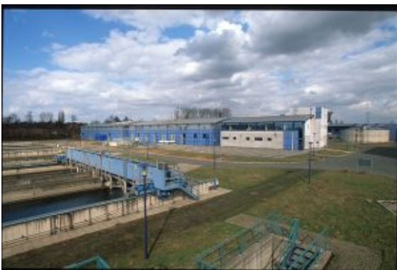
Die Kläranlage (KLG) Kamen-Körnebach. Foto: Lippeverband
