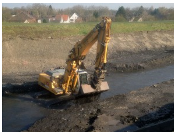
Bagger im Unterlauf der Seseke
