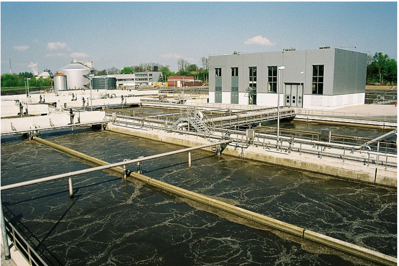
Kläranlage Lünen. Foto: Lippeverband
