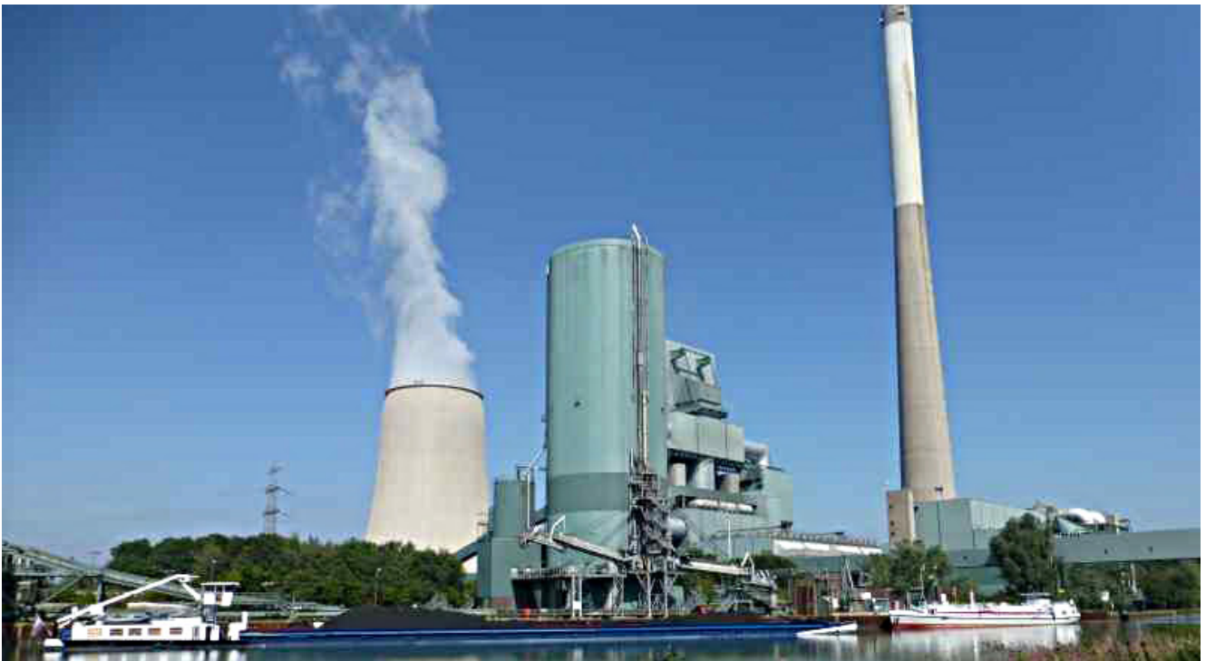
Das Steinkohlekraftwerk in Heil.
