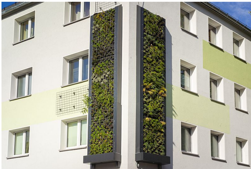
Fassadenbegrünung Gladbecker Straße in Essen
