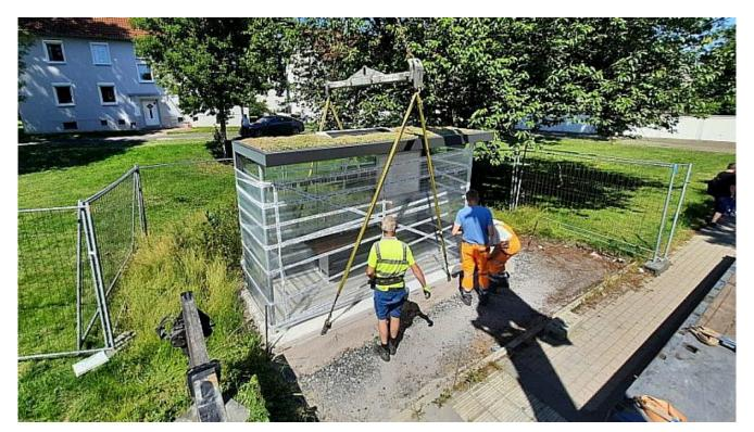
Erste Buswartehalle mit Dachbegrünung und Solarbeleuchtung steht an der Straße Am Römerberg in Oberaden.
