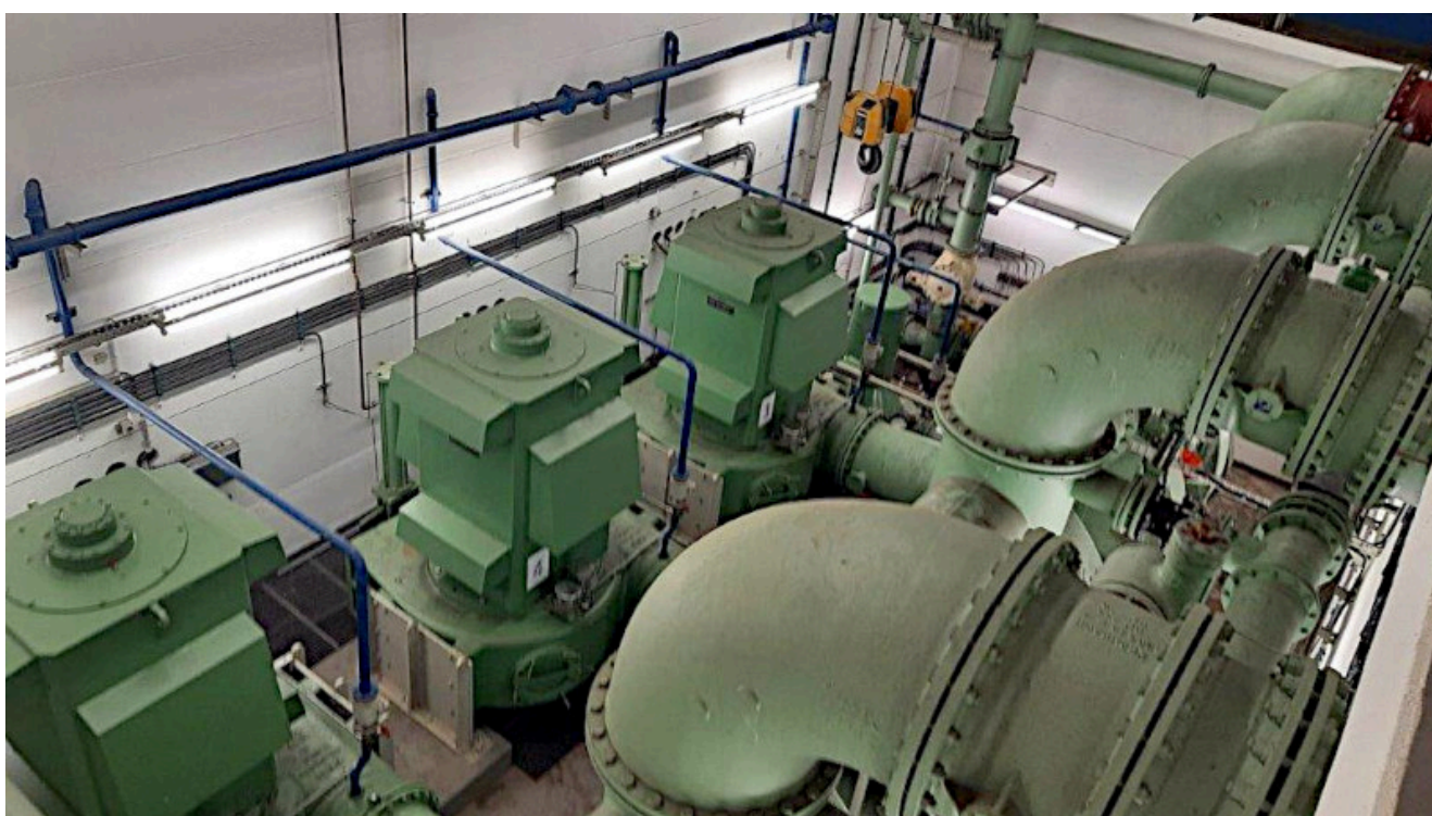
Pumpwerk Beverbach in Rünthe. Foto: Aktionskreis / Röcher
