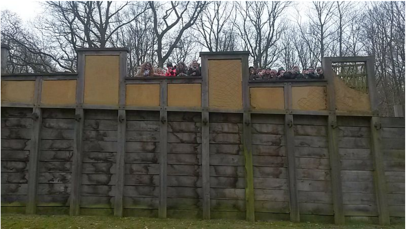
Verteidigung der Holz-Erde-Mauer. Foto: Gymnasium
