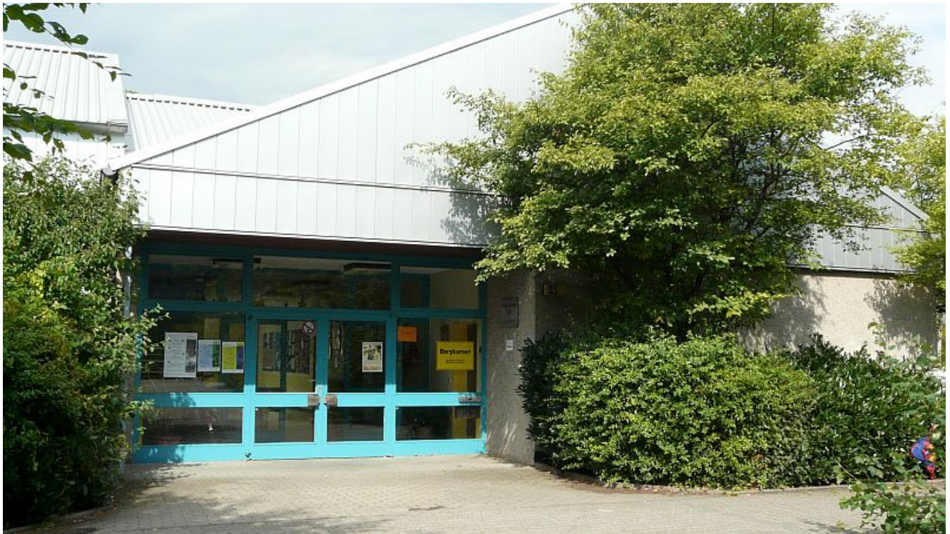
Haupteingang der Gerhart-Hauptmann-Grundschule.
