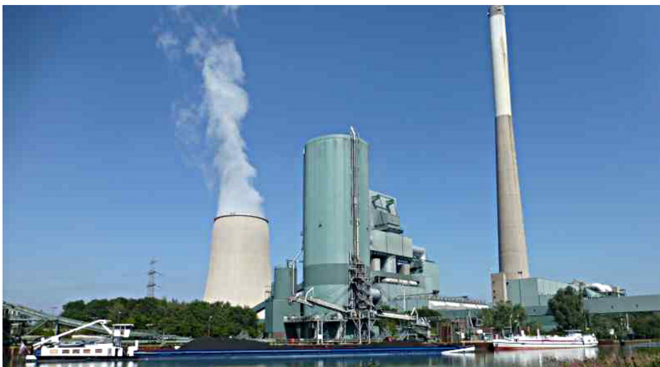
Das Steinkohlekraftwerk in Heil.
