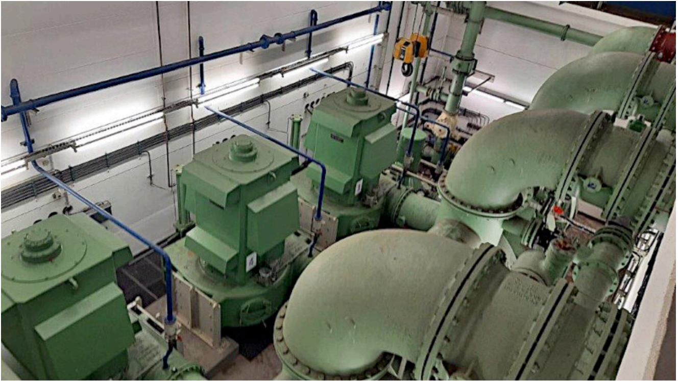
Pumpwerk Beverbach in Rünthe. Foto: Aktionskreis / Röcher
