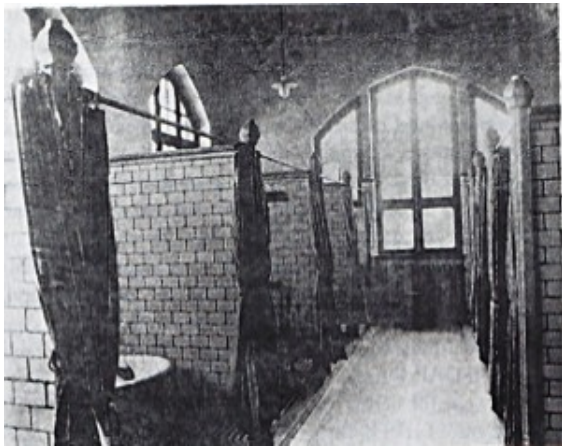
Waschkabinen im Wohlfahrtsgebäude
