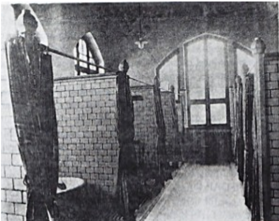
Waschkabinen im Wohlfahrtsgebäude
