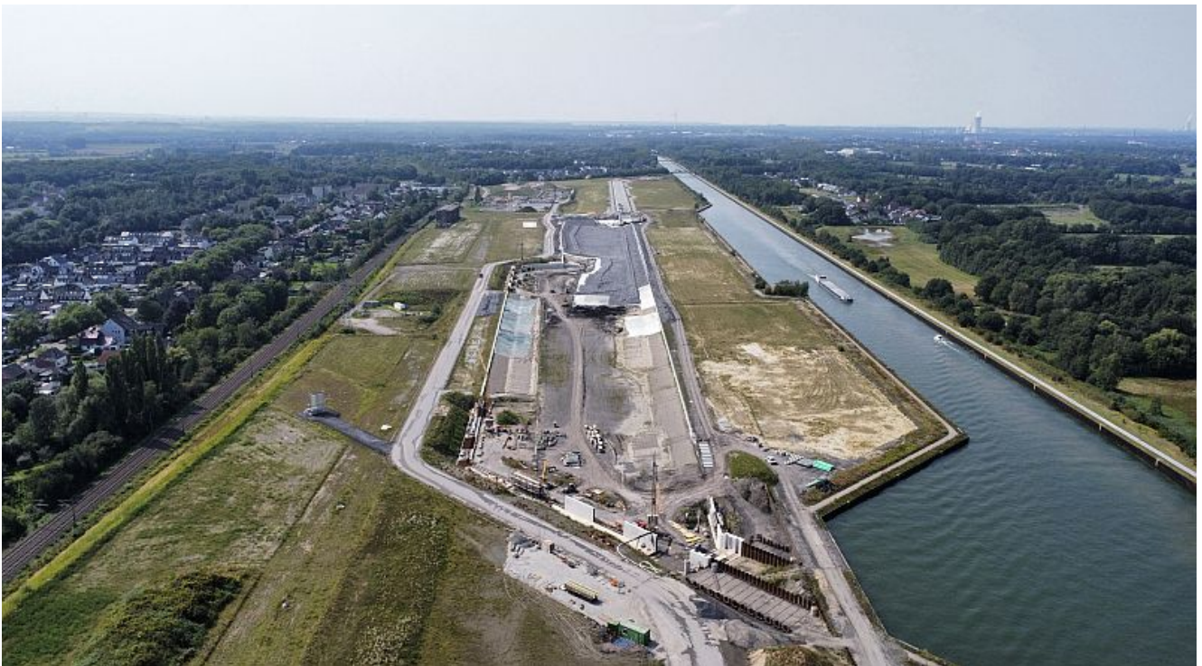
Großbaustelle Wasserstadt Aden.
