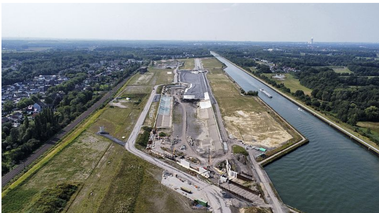
Großbaustelle Wasserstadt Aden.
