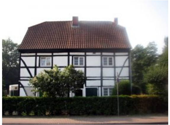
Fachwerkhaus Rotherbachstraße 157 in Oberaden
