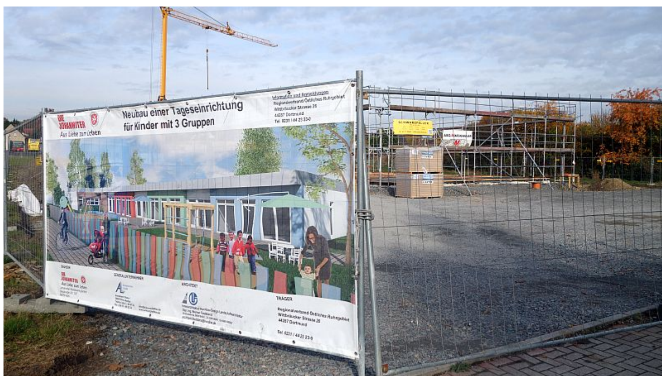
Kita-Baustelle ab der Eichendorffstraße in Bergkamen-Mitte.
