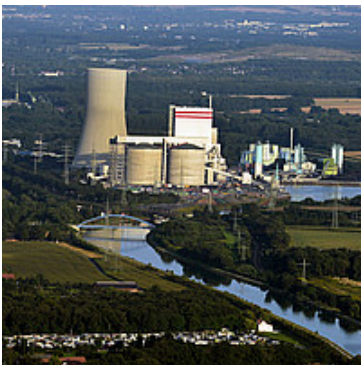
Trianel Kraftwerk Lünen
