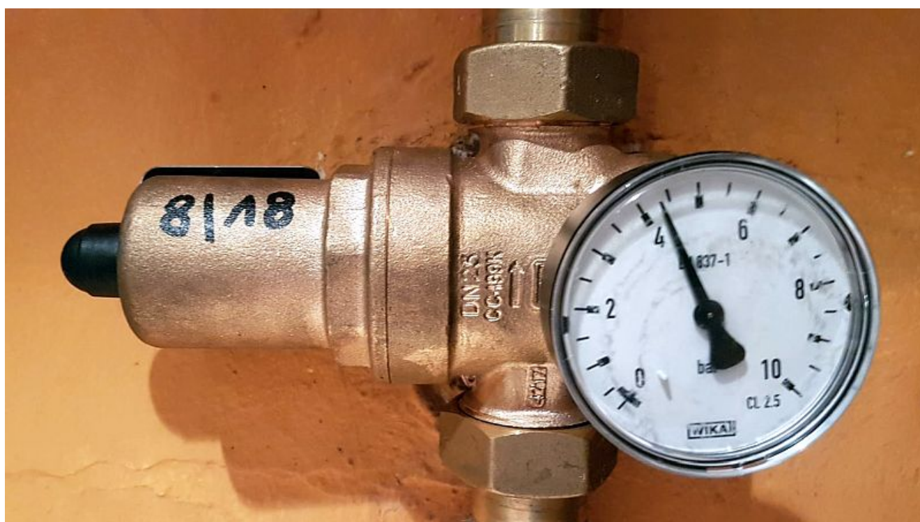
Druckminderventil mit Manometer.
