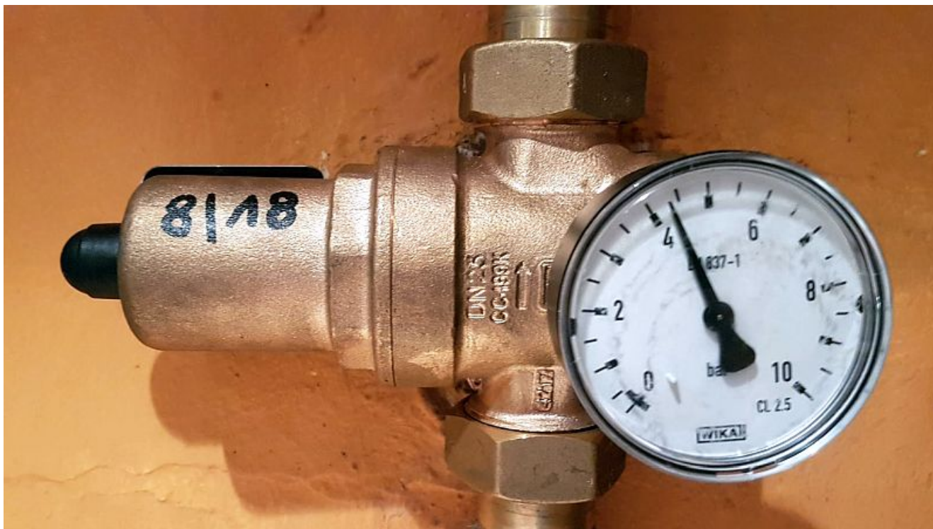
Druckminderventil mit Manometer.
