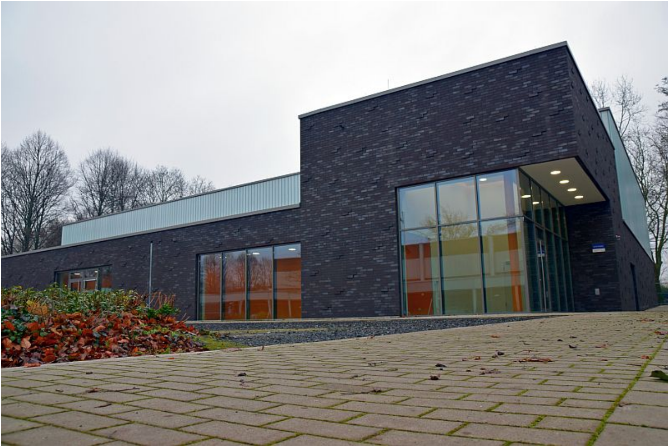
Die Kreissporthalle II an der Plantanenallee in Unna. Foto Anita Lehrke / Kreis Unna
