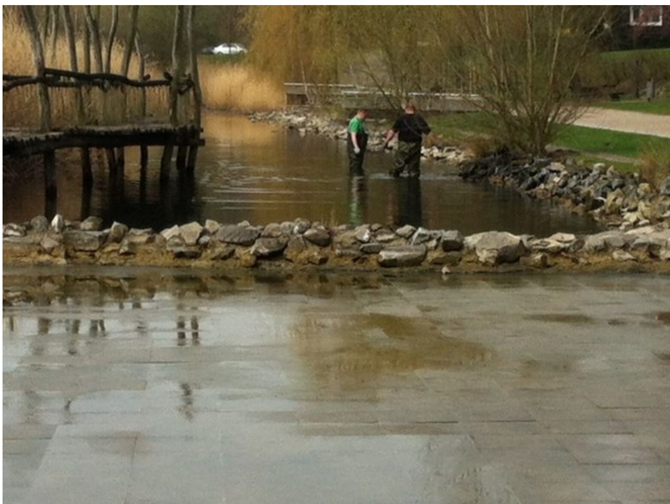
Reinigungsarbeiten im Teich im Wasserpark
