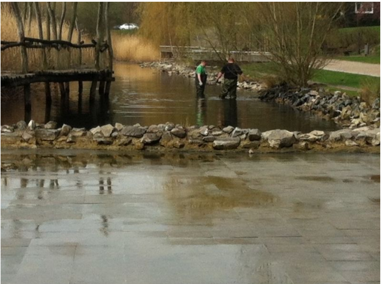
Reinigungsarbeiten im Teich im Wasserpark
