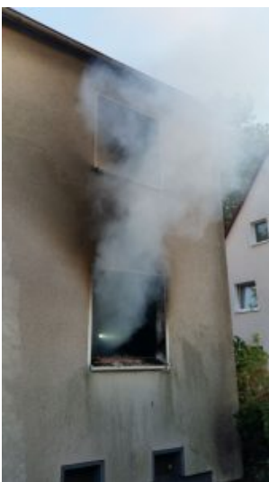
Dicke Rauchschwaden quollen aus dem Fenster der
