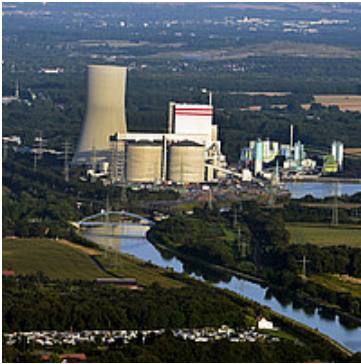
Trianel Kraftwerk Lünen
