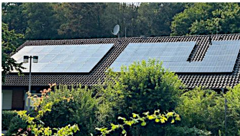
PV-Anlage auf dem Dach des Vereinsheims des
