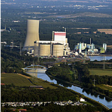
Trianel Kraftwerk Lünen
