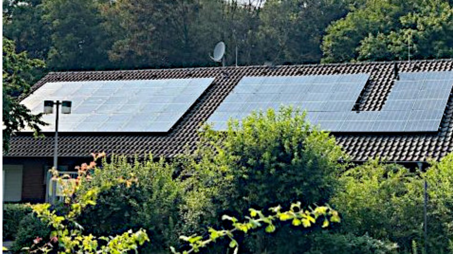
PV-Anlage auf dem Dach des Vereinsheims des Tennisvereins Blau-Weiß Bergkamen.
