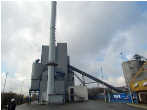
Biomasse - Heizkraftwerk Bergkamen
