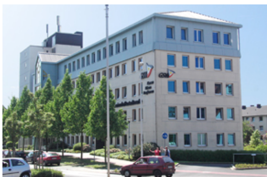
GSW-Gebäude in Kamen.
