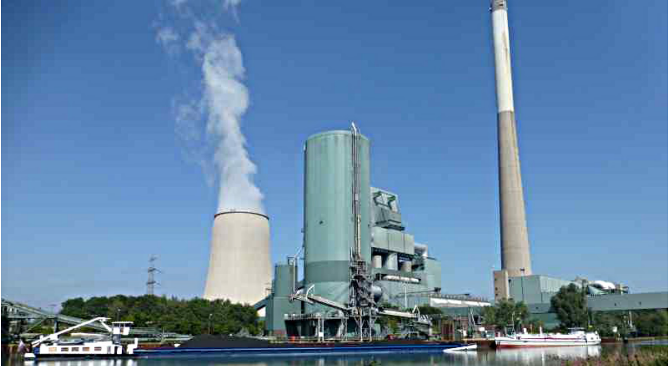
Das Steinkohlekraftwerk in Heil.
