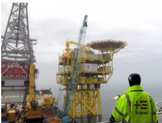
Bau der Umspannplattform
