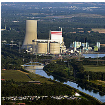
Trianel Kraftwerk Lünen
