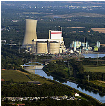
Trianel Kraftwerk Lünen
