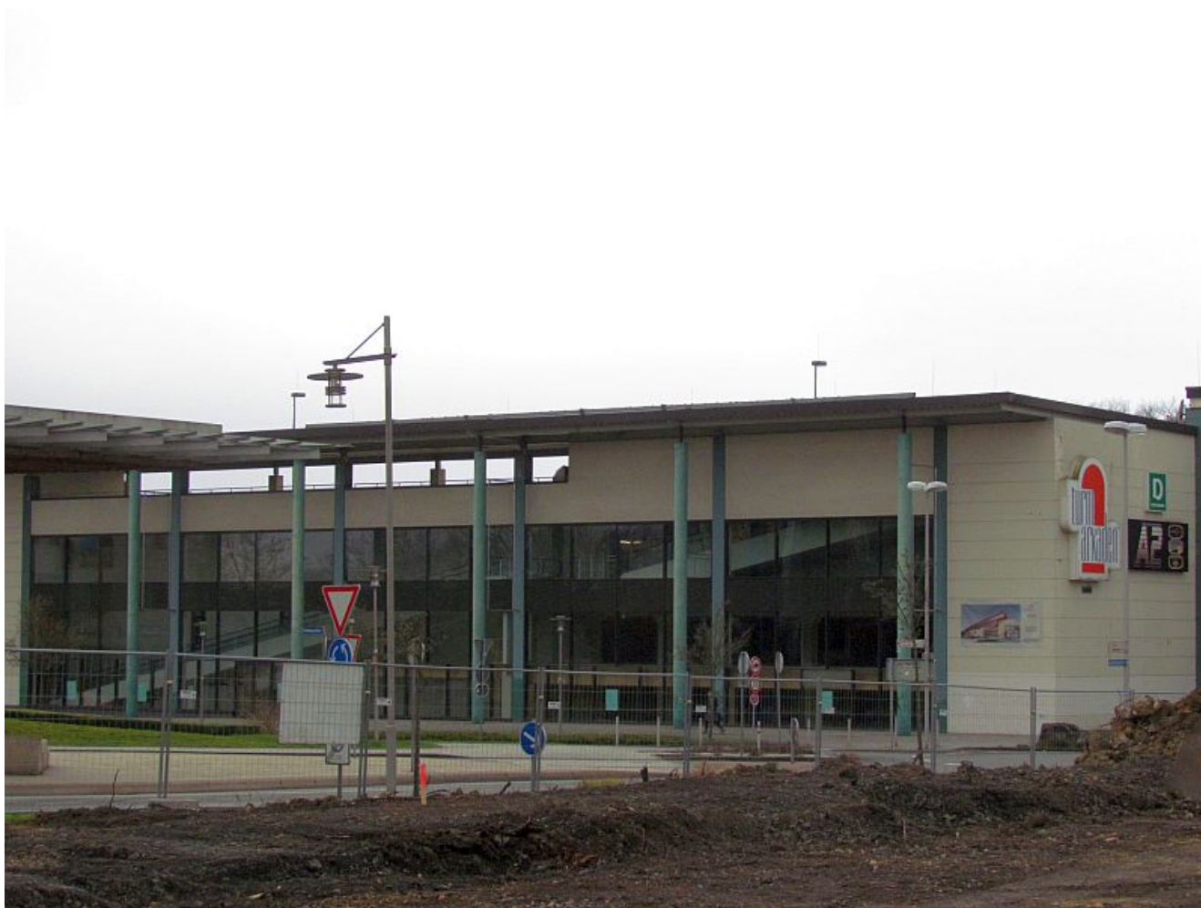
Die Turmarkaden mit Blick von der Sparkassen-Baustelle
